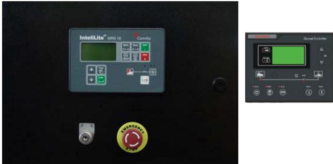
**控制器：**采用捷克科迈 Comap 、郑州众智科技 SmartGen 模块等智能控制器；
